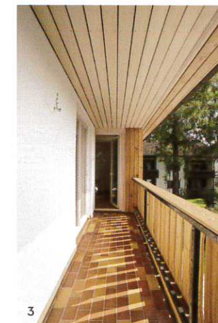
1 Die Traufseite bekam eine neue Fassaden- und Balkonverschalung.
